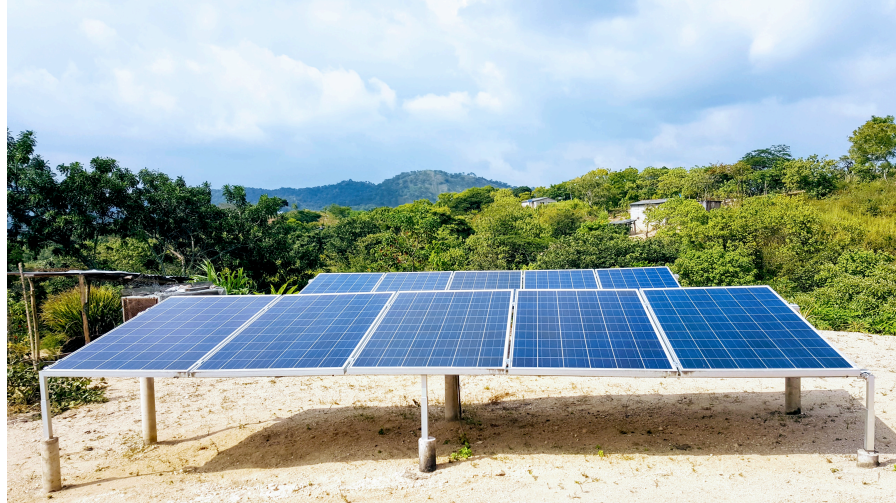
Figura 6. Minicentral Fotovoltaica de 2.5 Kw Implementada en la Comunidad El Tuzal, Municipio de Cintalapa, Chiapas. Foto: J. Moreira-Acosta.
