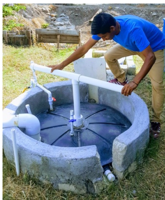
Figura 5. Biodigestor Anaeróbico de Tanque Plástico de 1100 litros. Foto: A. Aguilar-Castillejos
