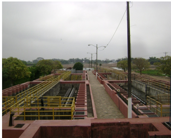
Figura 61. Reactor biológico anaerobio UASB. Fuente: Elaboración propia. Visita industrial FIQ.
