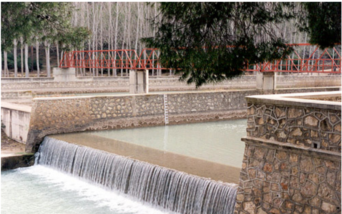
Figura 2. Vertedero Río Segura Murcia España Fuente: www.neetescuela.com/vertederos-hidraulicos
