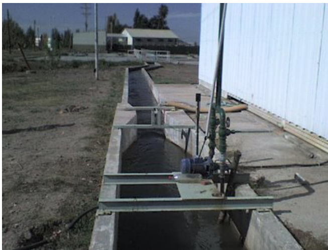
Figura 30. Desarenador flujo horizontal.
