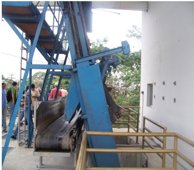
Figura 27. Criba equipo de desbaste. Fuente: EMSABA EP
