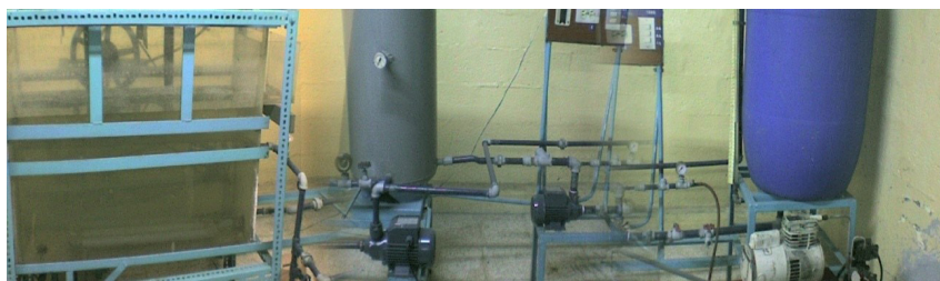
Figura 55. Sistema de flotación por aire disuelto. Fuente: Laboratorio de Aguas Fac. Ingeniería Química UG.
