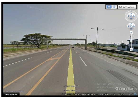
Ilustración 11: Vista panorámica de la calzada en la vía de estudio
