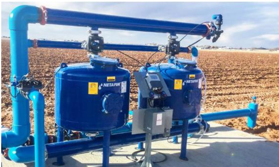
Figura 5.1: Filtros de arena o grava (fuente NETAFIM)
