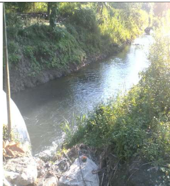
Foto N°32: Estero atravesando por el sector “La lejía 1”
