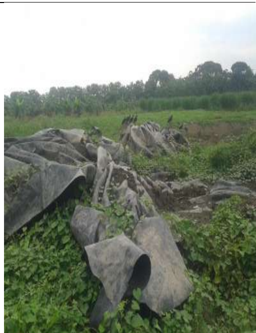
Foto N°22: Piscina numero 2 no operativa con la geo membrana dañada.
